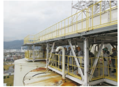
(バイオマスバンカ最上部の様子)
